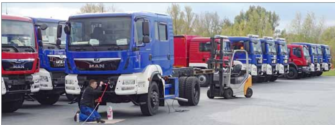
Von MAN kommen die Fahrgestelle, alles weitere am GWK macht Freytag. Der zweite Schritt nach dem Aufsetzen des Hilfsrahmens ist die Montage der Seilwinde. Diese wird dann auch vor Ort getestet.
